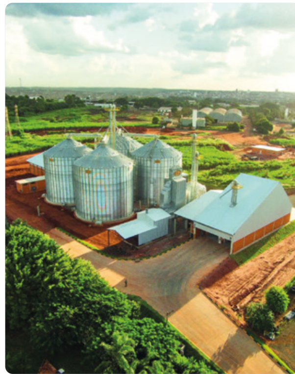
Silo de Grãos da Coopercitrus em Bebedouro-SP.
