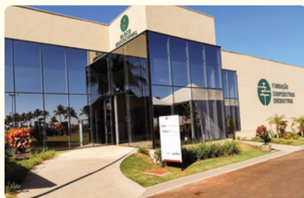
Prédio Educacional da Fundação.
